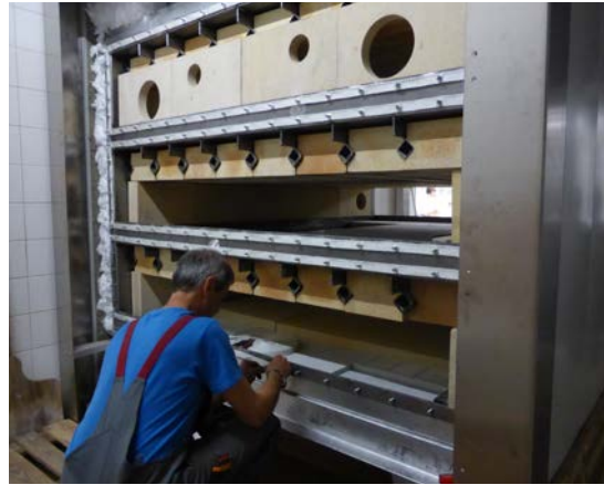
Einbau neuer Pellet-Backofen
