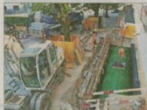
Alles ging glatt: Der Tank liegt im Loch und wird angeschlossen.
